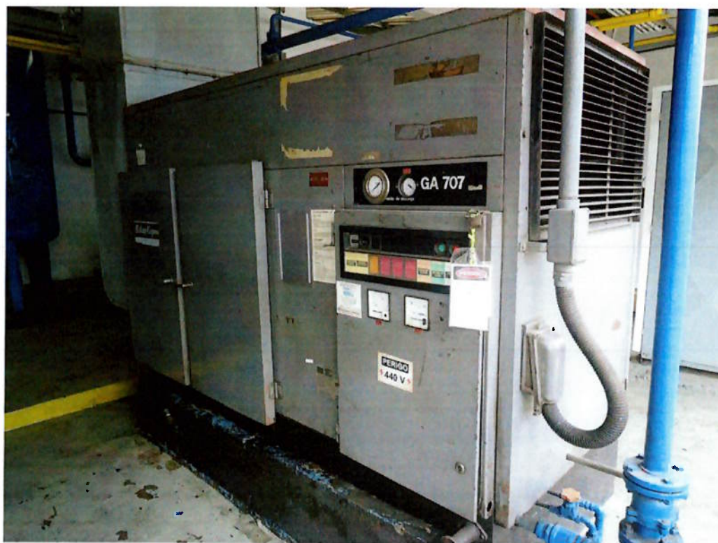
Figura 12: Compressor de ar Atlas Copco GA 707
