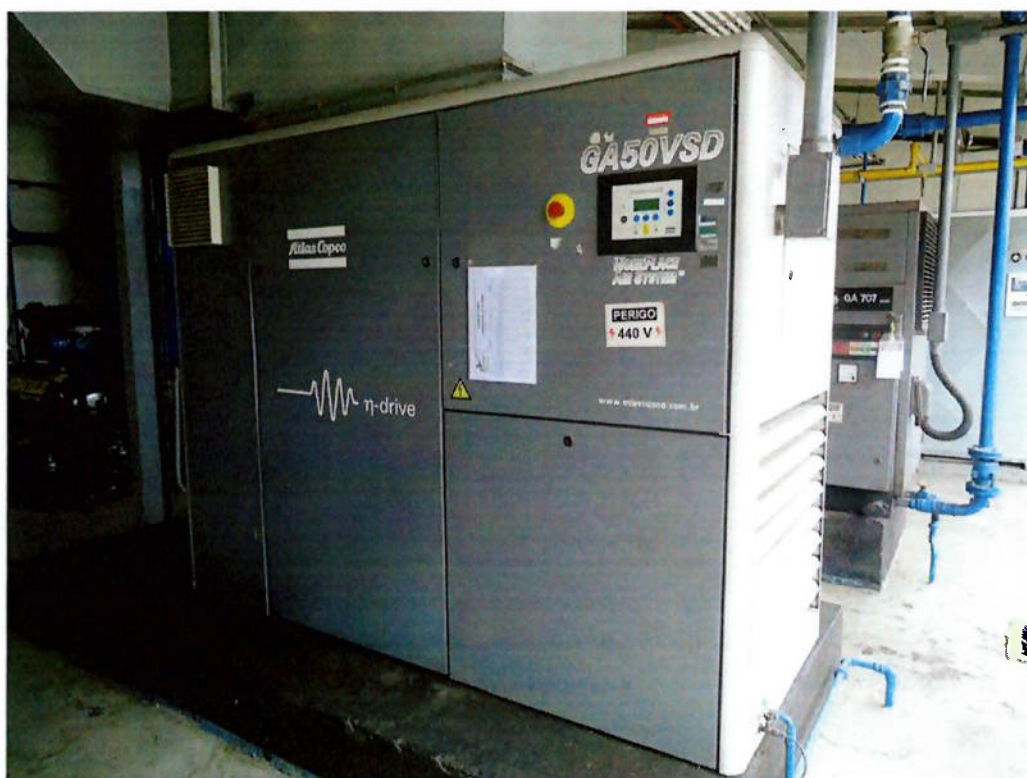
Figura 13: Compressor de ar Atlas Copco GA50VSD
