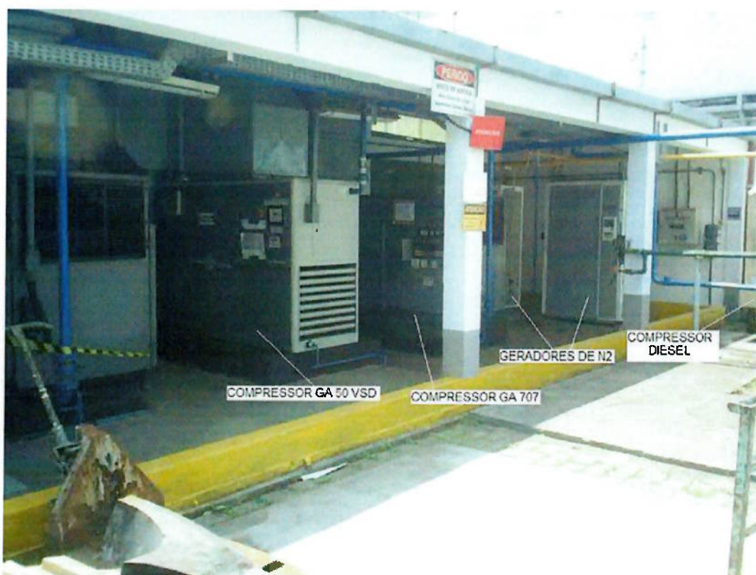
Figura 11: Sala de Utilidades 2 – Compressores e Geradores de N2
